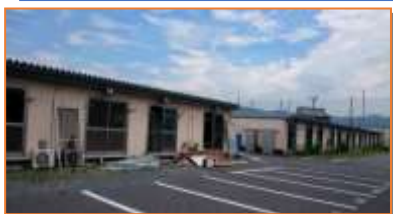
仮設住宅撤去作業中の様子 2017年7月
